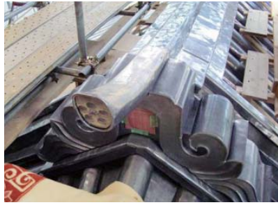
河北門（一の門）修復時の工事
